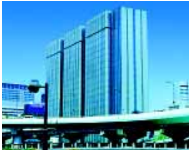
本社(大和堂島ビル1・6・7階)
